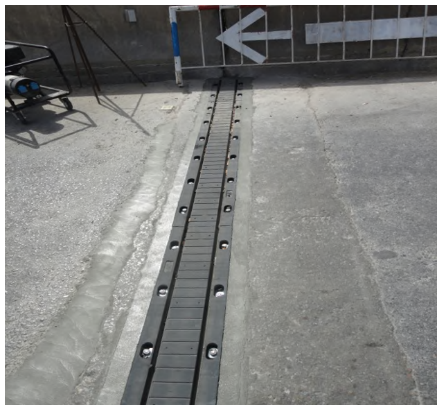
Vu du joint au lendemain de son exécution
