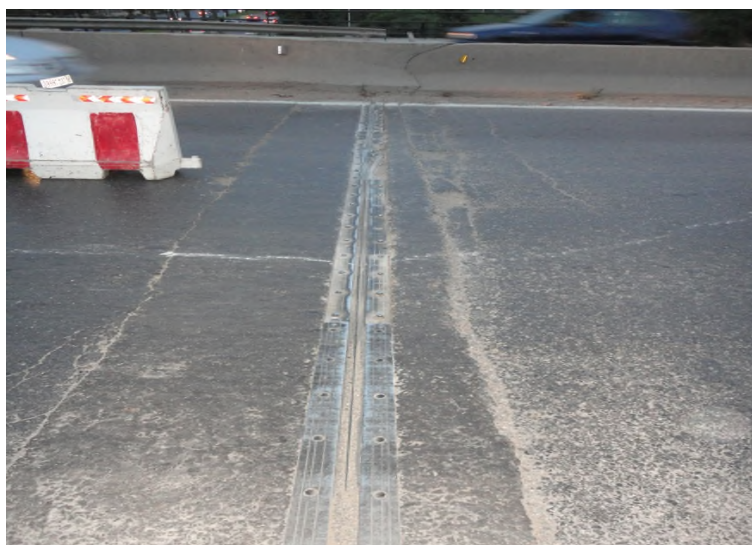
1er joint concerné par les travaux de réfection
